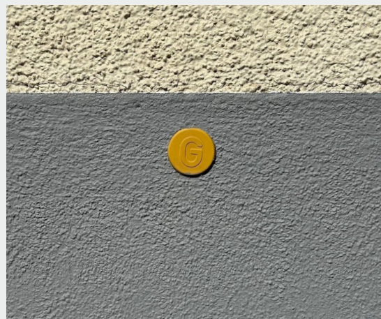
Markierung Gas-Anschlussleitung
