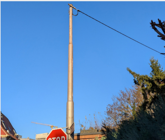
Freileitung Niederspannung
