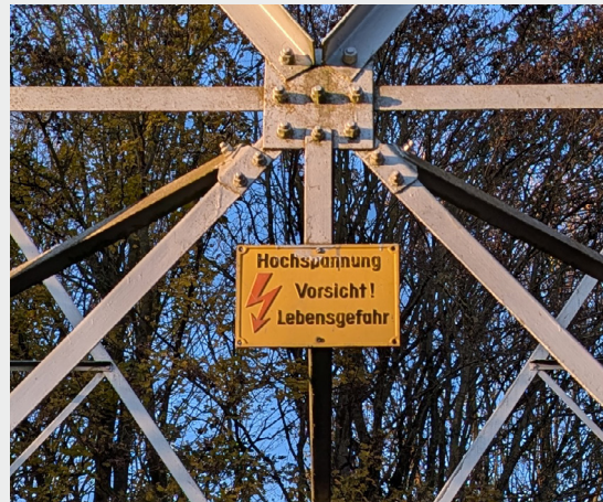
Hinweisschild Freileitung Hochspannung
