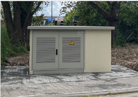
Trafo-Kompakt-Station
