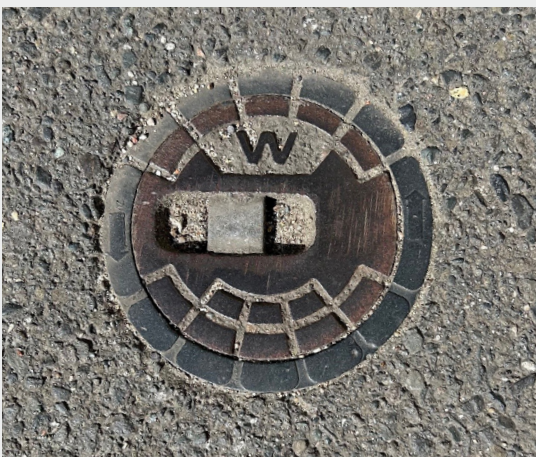
Schieberkappe Netzanschluss
