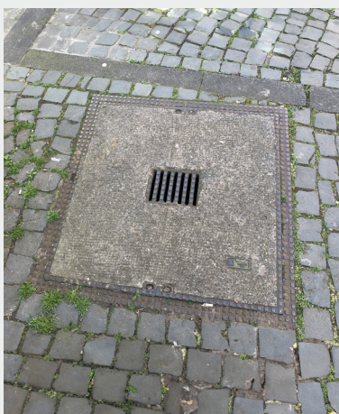
Kabelschacht
