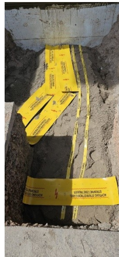
Abbildung 21: Trassenwarnband schmal
