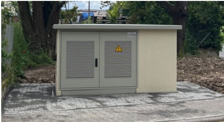
Abbildung 18: Trafo-Kompakt-Station
