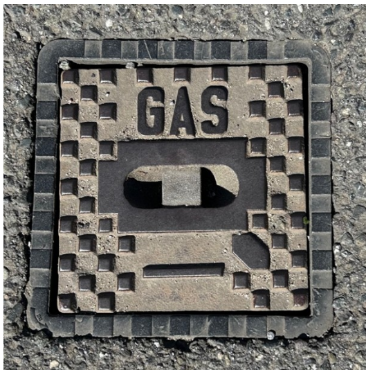
Abbildung 6: Schieberdeckel Gas
