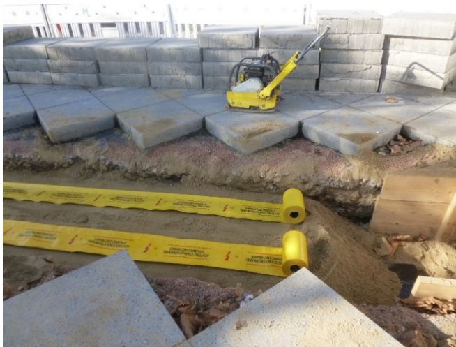
Abbildung 20: Trassenwarnband breit und breit
