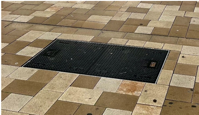
Abbildung 15: IKT-Schacht
