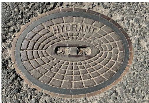
Abbildung 9: Hydranten-Deckel
