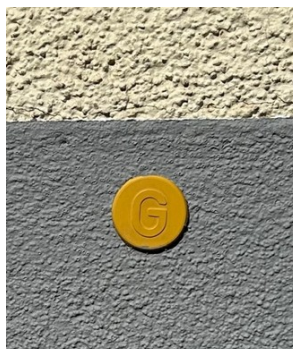
Abbildung 5: Markierung Gas-Anschlussleitung
