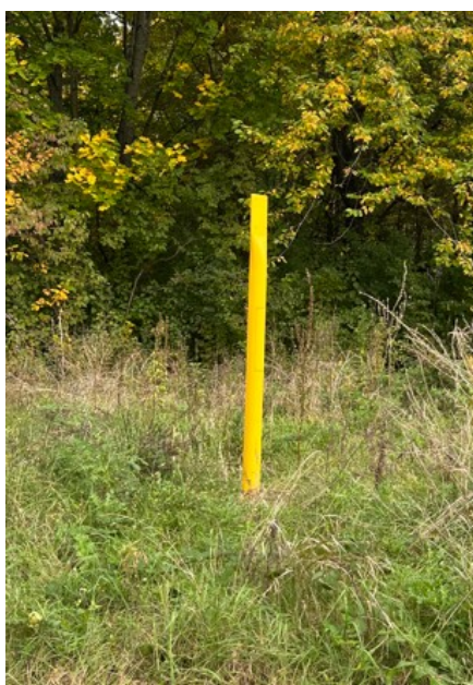
Abbildung 3: KKS Messtellenpfosten Gas-HD
