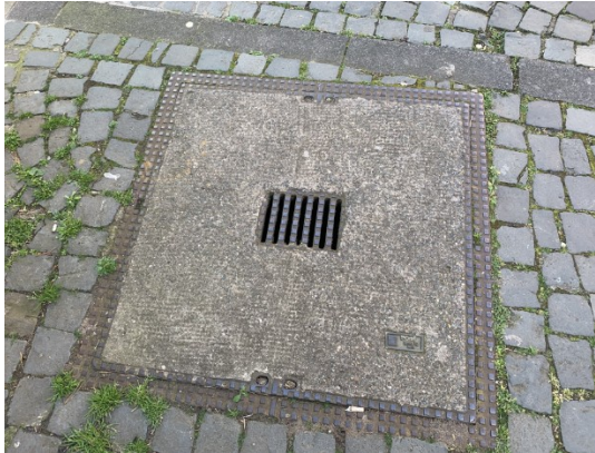
Abbildung 13: Kabelschacht
