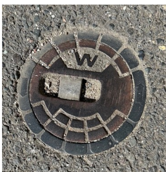
Abbildung 4: Schieberkappe Netzanschluss
