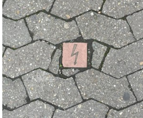
Abbildung 14: Markierungsstein Strom
